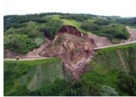
Glissement de terrain
