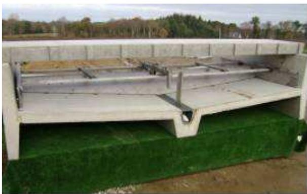
*Photographie 1 : la forme du racler est adaptée au fond de fosse en V. La gouttière centrale collecte les urines.*
